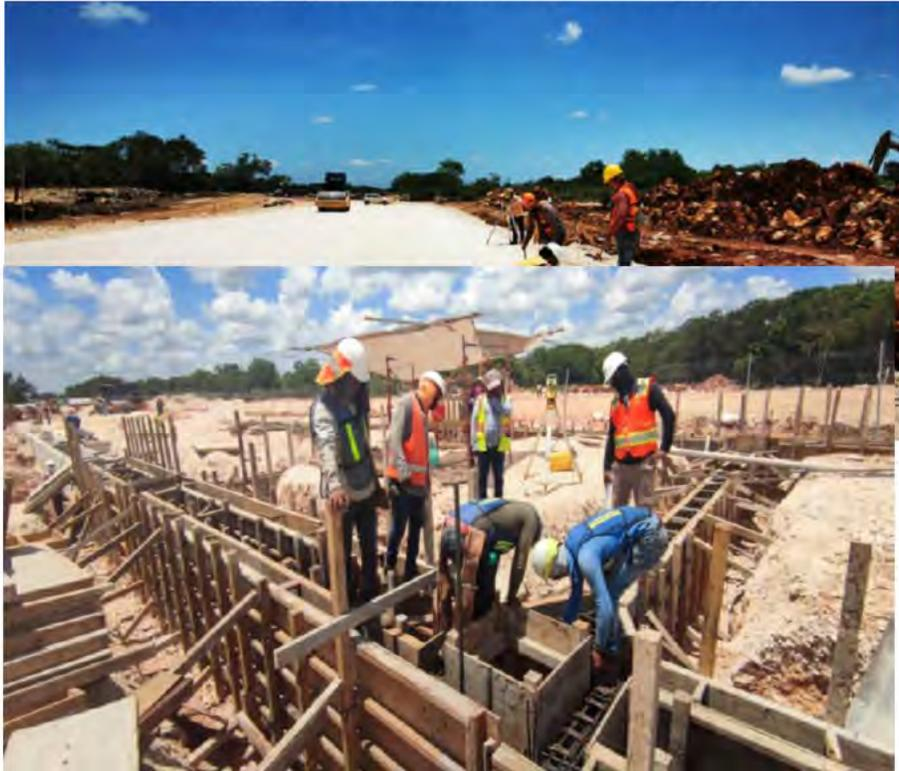
Conformado de plataforma con material de banco y trazo de cimentación de la estación Hecelchakán.
