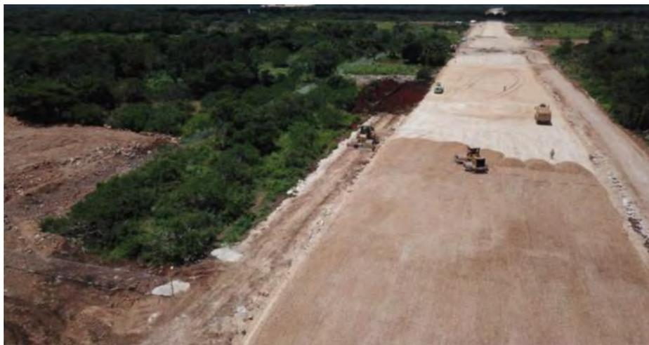
Trabajos de desmonte y despalme Estación. Tenabó
