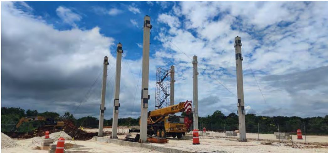
Montaje de 6 columnas prefabricadas
